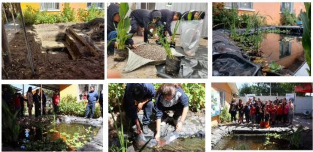
Fotos del proceso de escuela Valdivia de Paine
